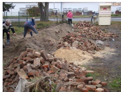
Oczyszczanie terenu przy kościele
